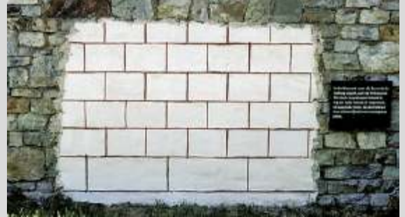
Abb: 17/18: Oben das Teilstück an der TvQ-Schule in Walberberg. Unten ein rekonstruierter Verputz aus Kalkmörtel mit Quaderfugenmalerei an der „Saalburg“ am Römischen Limes in Bad Homburg vor der Höhe Fotos: FHW/Keßler
